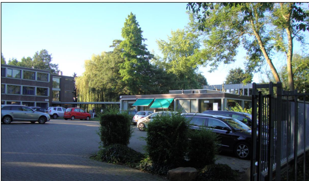
Foto zuidwestelijke ingang campusterrein, met op de achtergrond het portiers-/bewakingsgebouw.
