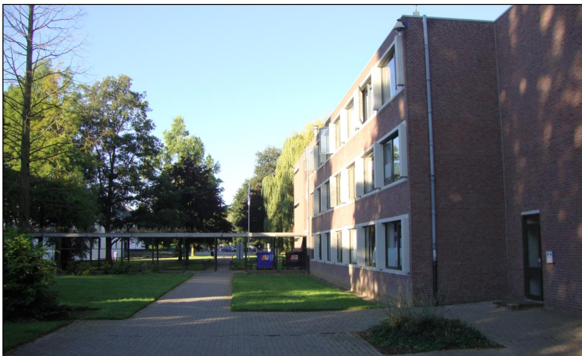
Eén van de bestaande woongebouwen, bestaand uit drie bouwlagen
